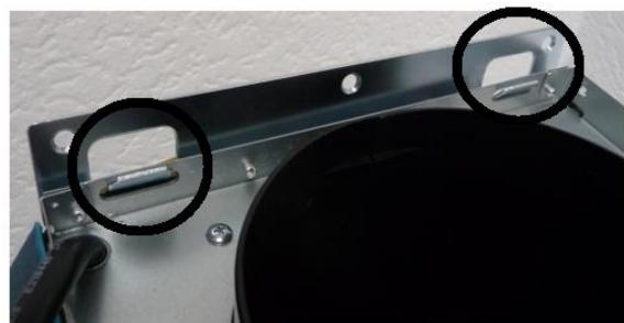
6. Bringen Sie das Flacheisen zuerst am unteren Kamin und dann an der Wand an. Sie können diesen Schritt zuerst provisorisch vornehmen, um die Löcher für die Wandmontage des Flacheisens anzulegen und die entsprechenden Bohrungen in der Wand vorzunehmen.
