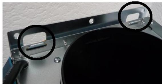
6. Bringen Sie das Flacheisen zuerst am unteren Kamin und dann an der Wand an. Sie können diesen Schritt zuerst provisorisch vornehmen, um die Löcher für die Wandmontage des Flacheisens anzuzeichnen und die entsprechenden Bohrungen in der Wand vorzunehmen.
