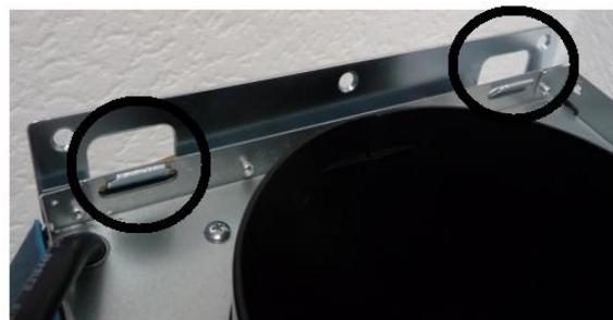
6. Installeer de flat bar eerst op de onderste afzuigkap, daarna op de muur. U kunt deze stap voorlopig uitvoeren, om de boringen van de wandmontage te markeren en de betreffende gaten te boren.
