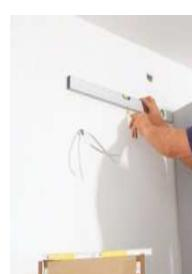
Montieren Sie zunächst die Unterschränke und richten Sie diese mit einer Wasserwaage aus.
